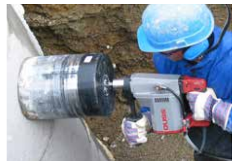
Anbohren von Betonschacht – nass, handgeführt
