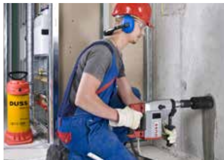
Dosensenken in Beton – nass, handgeführt
