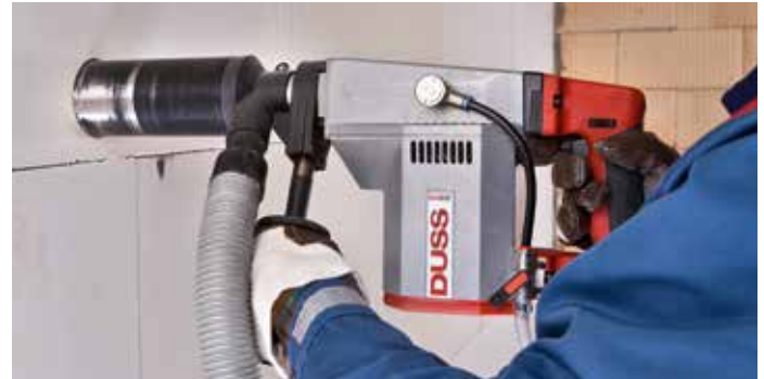
Dosensenken trocken in Kalksandstein mit Staubabsaugung
