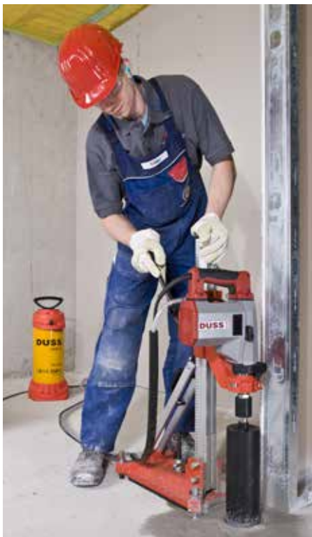
Nassbohren in Beton, ständergeführt
