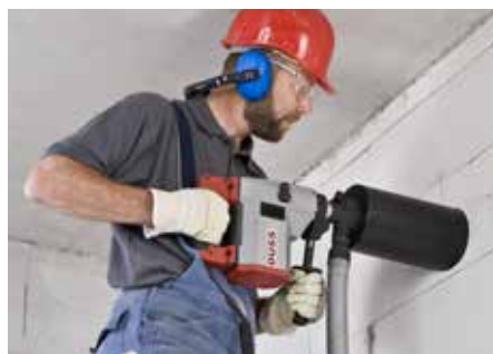
Trockenbohren in Mauerwerk mit Staubabsaugung, handgeführt
