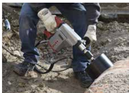
Anbohren von Kunststoffrohr – trocken, handgeführt
