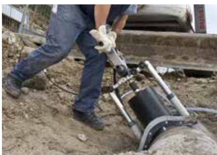
Anbohren von Betonrohr – nass, stativgeführt
