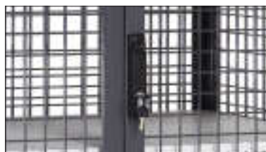
Treibriegelverschluss mit Schwenkhebel und Zylinderschloss.
